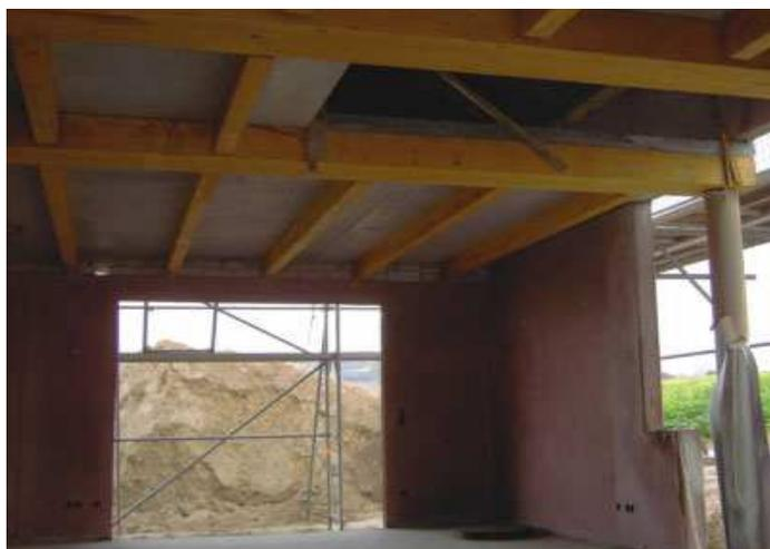
**Figura 1** – Estrutura mista de madeira e concreto.
