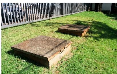
**Figura 3** – Cisterna responsável pela captação da água da chuva
