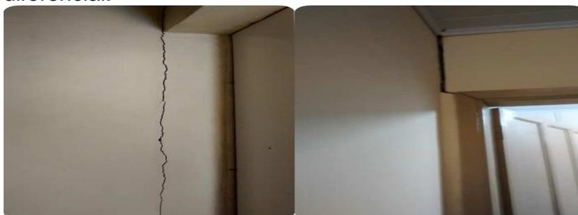
**Figura 1** – Fissuras na edificação conseqüentes do aterro vizinho.
