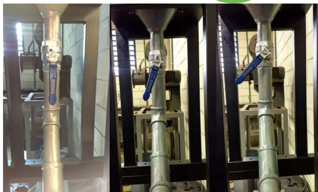
Figura 5 – Abertura da válvula de entradas dos ensaios 1, 2 e 3, respectivamente.
